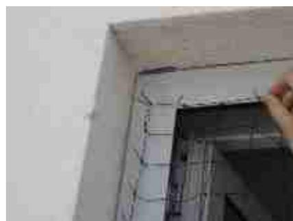
Puis 3 mailles sans FIXNET à la 4<sup>ème</sup> « clipper » le filet dans le FIXNET dans l'angle ceci permettant de tendre le filet (voir ci-dessous)
