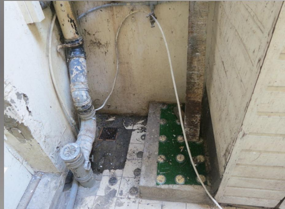
Des pigeons qui nichent dans le coin des balcons est un problème commun. Dans ce cas, le nid doit être retiré et quatre coupelles fixées dans un carré à 15cm (centre à centre) à l'endroit du nid.
