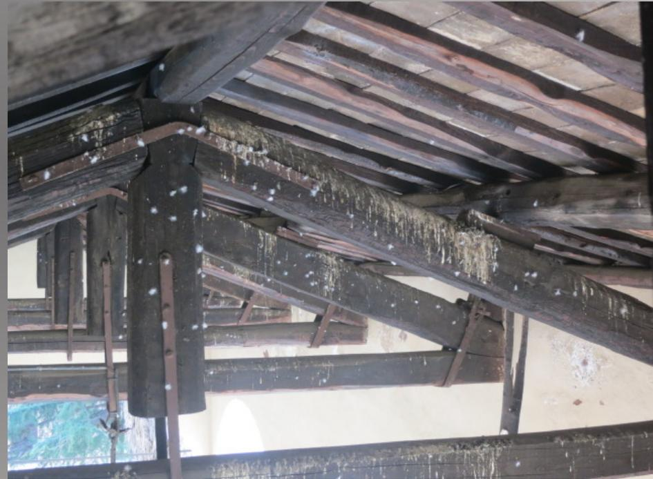
Les charpentes ont d'abord été nettoyées. Des coupelles de *Bird Free* ont ensuite été collées sur les parties supérieures des charpentes à 20cm centre à centre (en bas à gauche), et sur la partie inférieure des charpentes à 25cm (en bas à droite).
