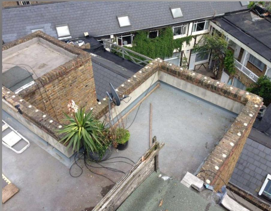
Si le rebord a plus de 25cm de profondeur et s'il y a des nids ou des perchoirs de nuit dans le voisinage immédiat du rebord, deux lignes de coupelles doivent être posées. Les coupelles doivent toujours être collées dans les coins de la corniche parce que les oiseaux préfèrent les coins abrités.
